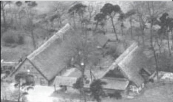
Alter Kirchweg 1 (Luftfoto 1977, Brand 1995). Eindrucksvolles Ständerwerk des erhaltenen Nebengebäudes.
