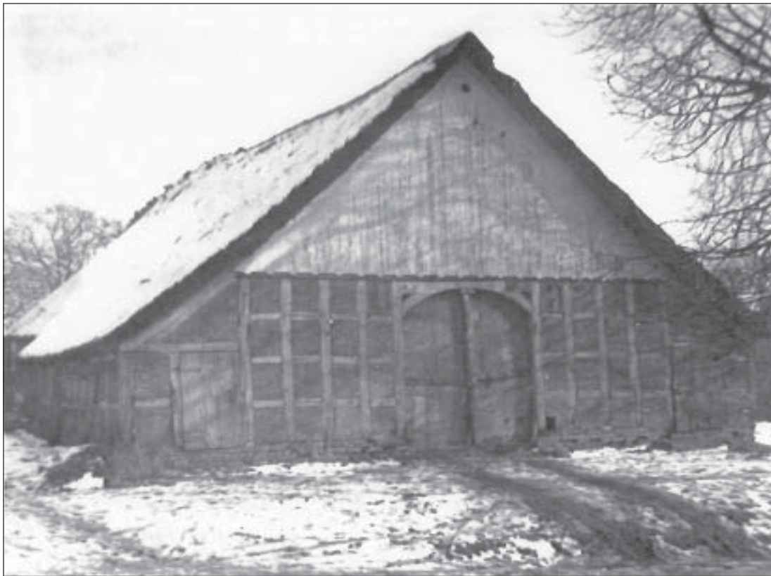
Ehemaliges Haus von J. und M. Meyn (1925 ausgewandert nach USA) zwischen Ortsstraße 36 und 38. Abgerissen 1962. Rechts am Bildrand: die „Meynsche Kastanie“. (Später wohnte hier Oma Alpers. Siehe dazu S. 417 und S. 422)
