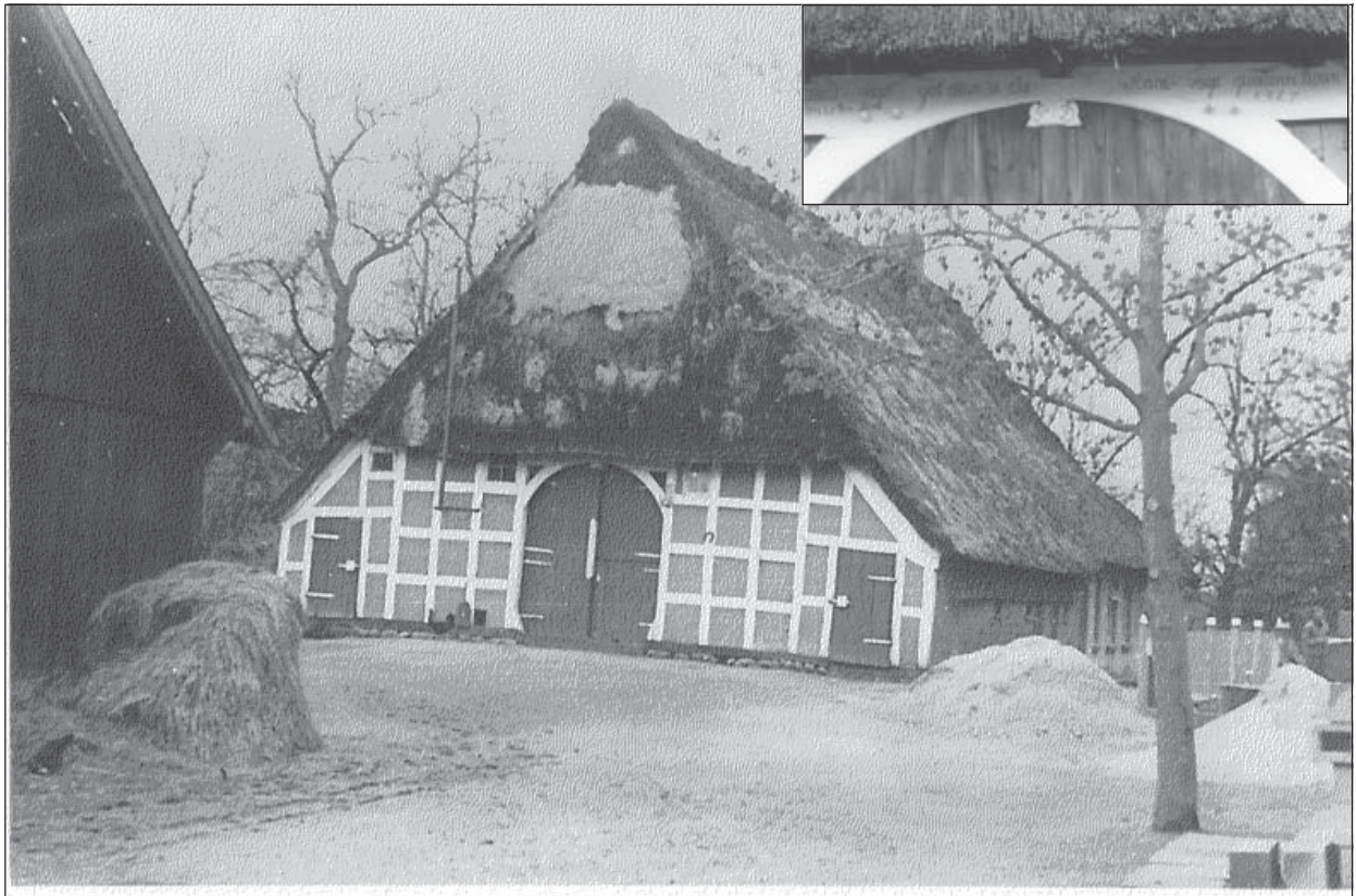
Zwischen Ortsstraße 39 und 41 (abgerissen um 1970). Früher Familie Quell, dann Sturm. (Oben rechts: der alte Balken der Dielentür des Hauses - heute Nebengebäude Kirchweg 2).
