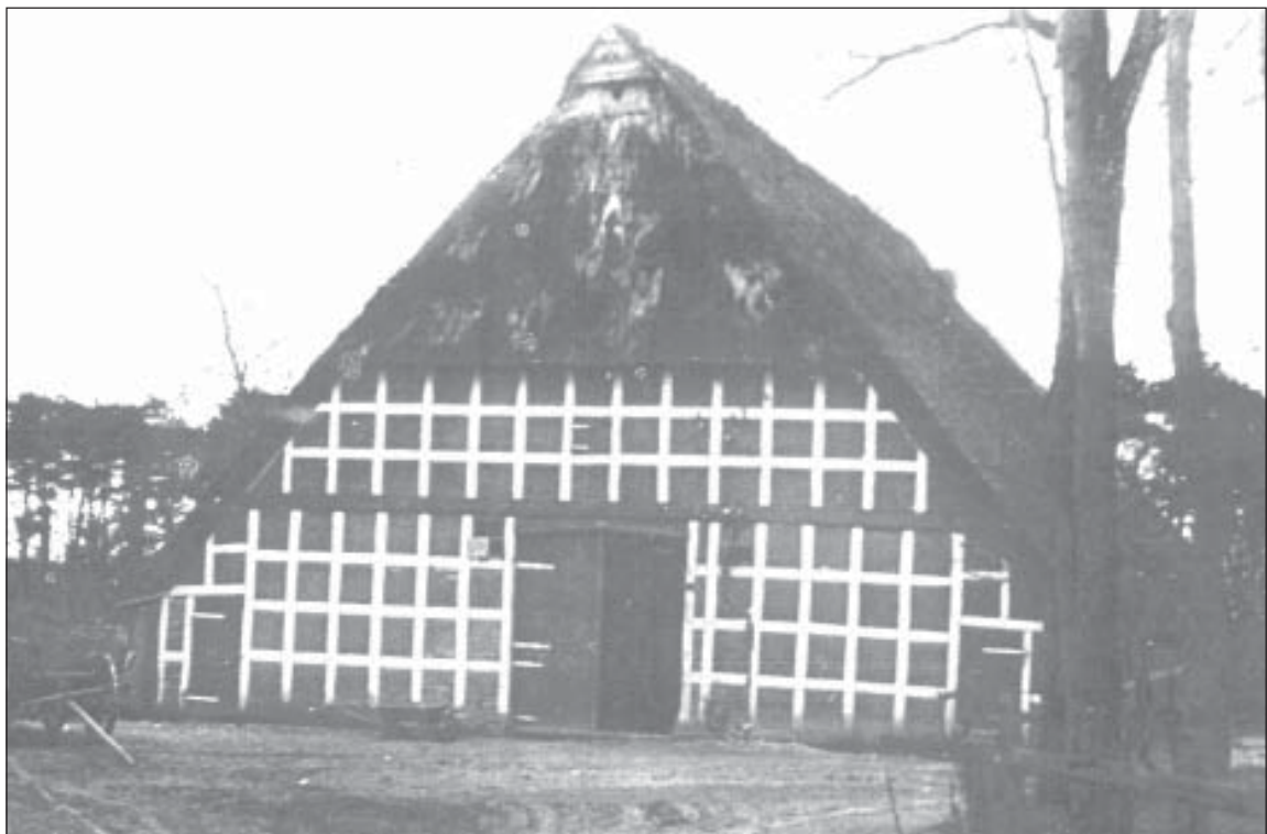
Der alte Hof Tiedemann/ Wilkens Ortsstraße 31.
