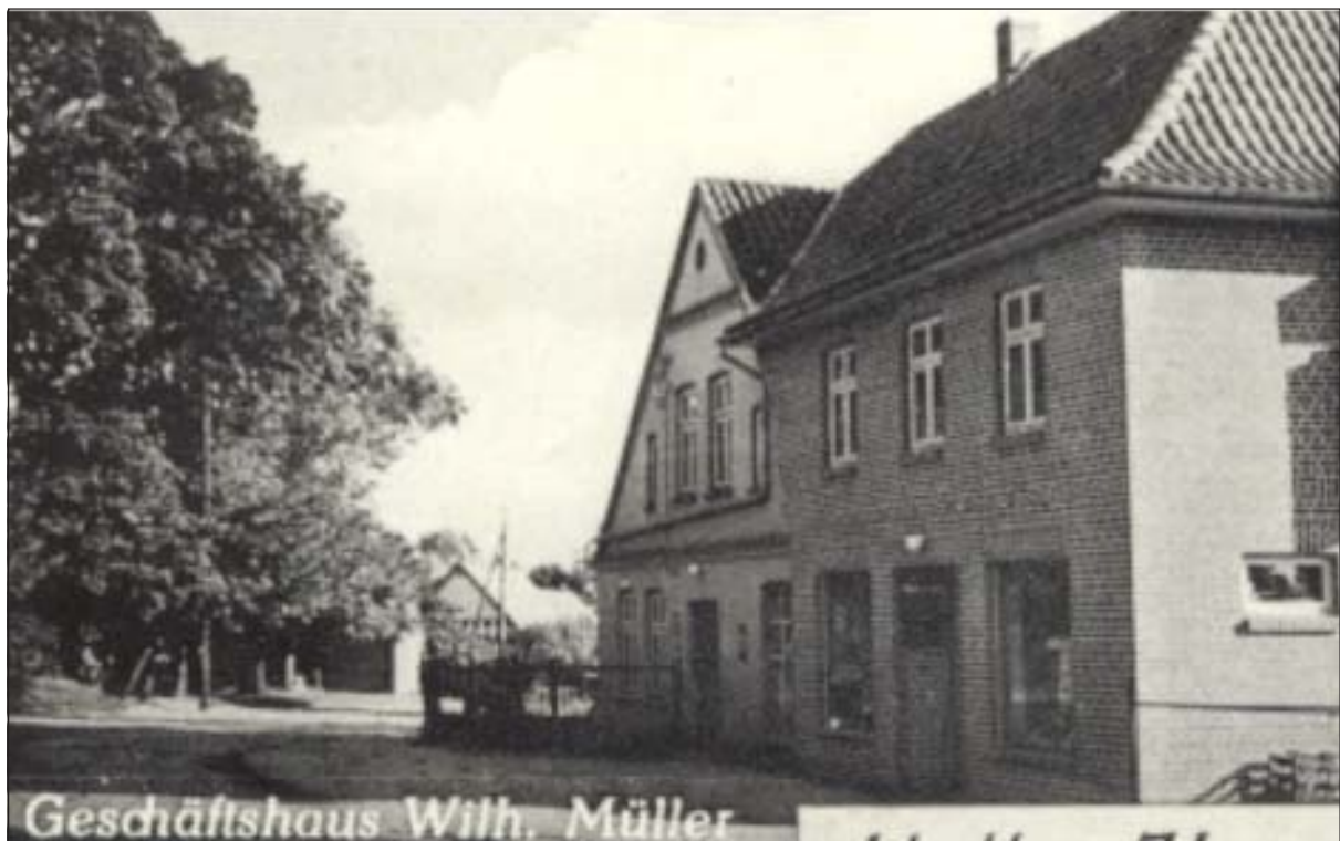
Ortsstraße 15 (1954). Beginn des Umbaus.
