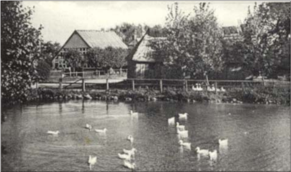
Unterer Notteich (1954) mit Blick auf Ortsstraße 16 (l.). Rechts der früher einmal als Schmiede benutzte Fachwerkschuppen von Ortsstraße 13.
