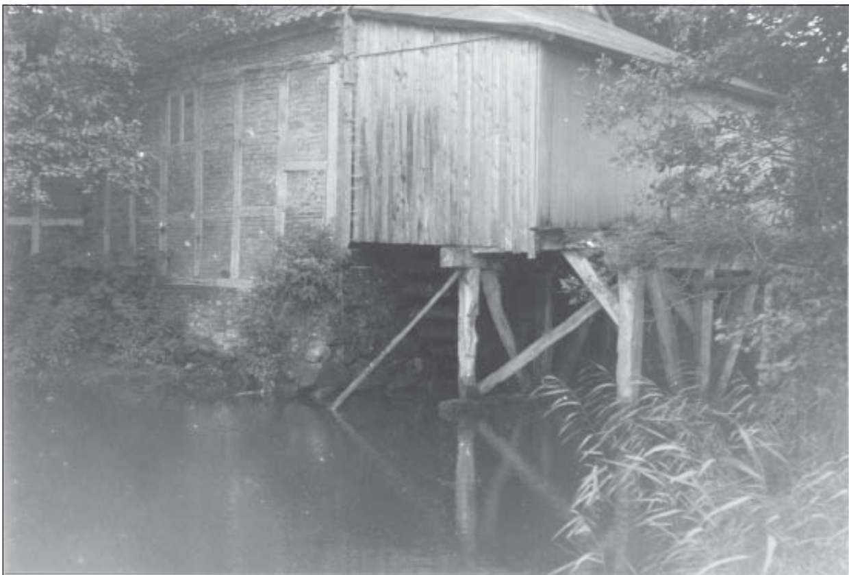
Radhaus der Hollener Wassermühle (unbekanntes Datum).
