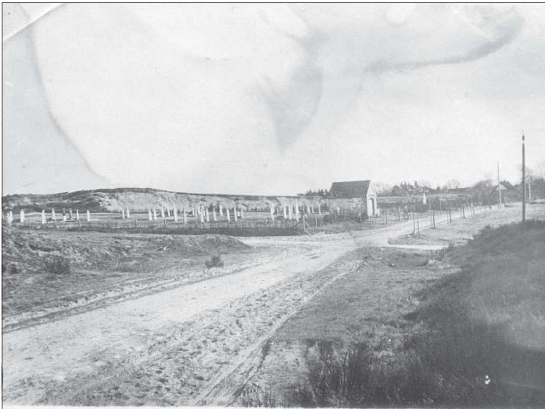
Der 1905 in einer Sandgrube angelegte neue Friedhof (unbekanntes Datum). (Heinrich Buck, Fischerhude)
